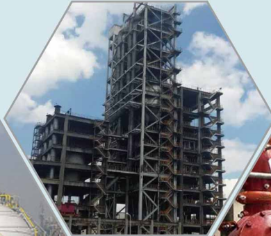
装置喷淋 冷却系统
