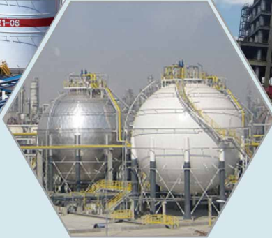
球罐喷雾 灭火系统
